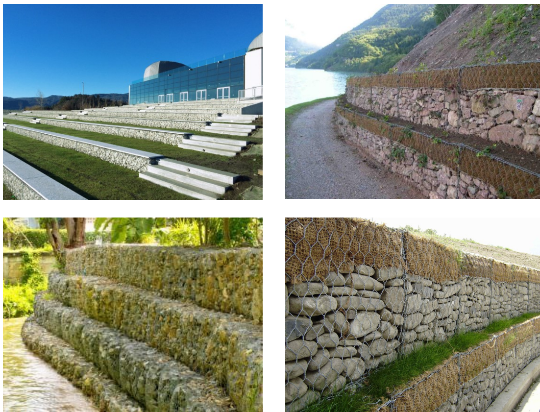
Figura 15 - Esempi di gabbioni per ingegneria naturalistica
